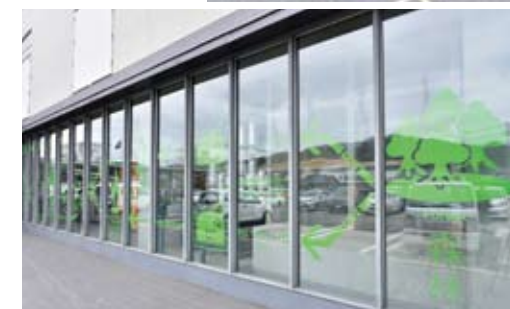
上/2011年完成の真庭市役所では、庁舎前のバス待合所にCLTを使用。下/市庁舎の冷暖房を担う、ガラス張りのボイラー室。ガラスには、森の木が木質バイオマスとして燃料となるしくみが、わかりやすく描かれている。
