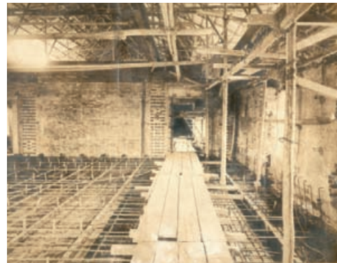
写真10 「本館」3階事務室の復旧工事。内装のほか、床板・屋根も取り除かれています(写真3参照)。(日本銀行情報サービス局所蔵)
