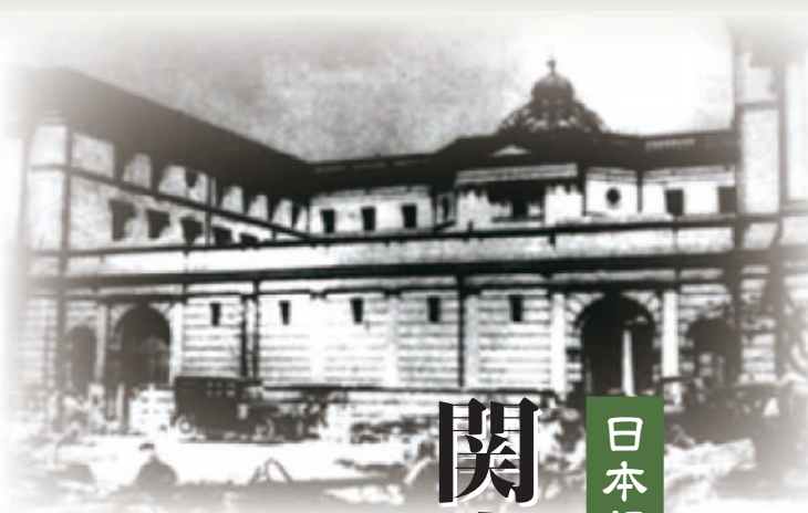
被災した本館建物外観
