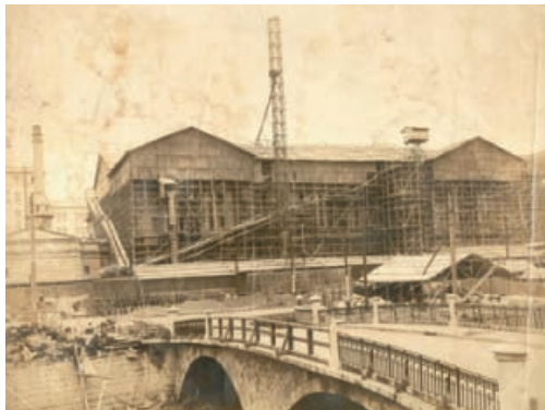
写真11 仮設屋根で覆われた「本館」復旧工事(日本銀行情報サービス局所蔵)
