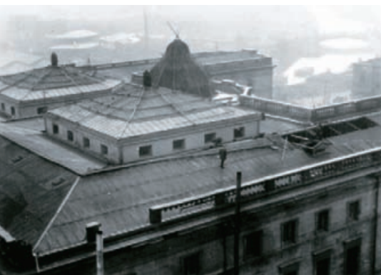
写真9 「本館」屋上の被災。焼失したドーム屋根とガラス屋根(日本銀行金融研究所アーカイブ所蔵)
