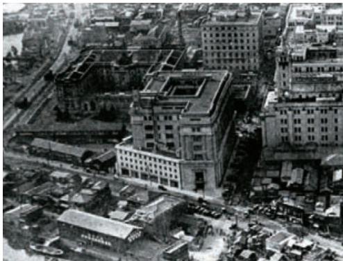
写真12 上空から見た復旧後の「本館」(写真左奥の低い建物)。本館右奥の北分館はこの後、3階建てに部分取り壊し。昭和3年(1928)頃撮影。(日本銀行金融研究所アーカイブ所蔵)
