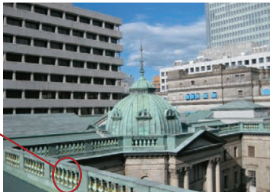
写真8 バラストレート。円形線形の装飾柱を用いた屋上手すり
