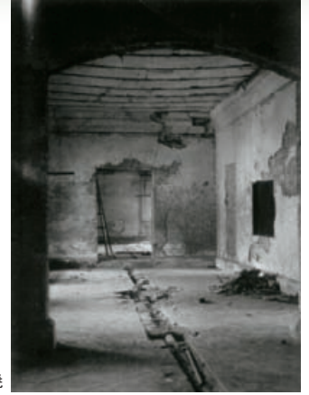
写真3 「本館」3階事務室の被災(日本銀行金融研究所アーカイブ所蔵)
