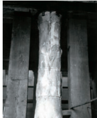
写真4 「本館」営業場柱の被災。細く焼け残った柱の両脇を木製柱で応急補強(日本銀行金融研究所アーカイブ所蔵)
