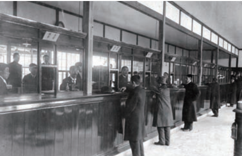
写真2 同口ビル風景
