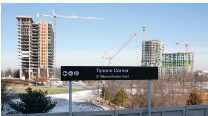
シルバーラインが開通した駅周辺で進むビル建設
