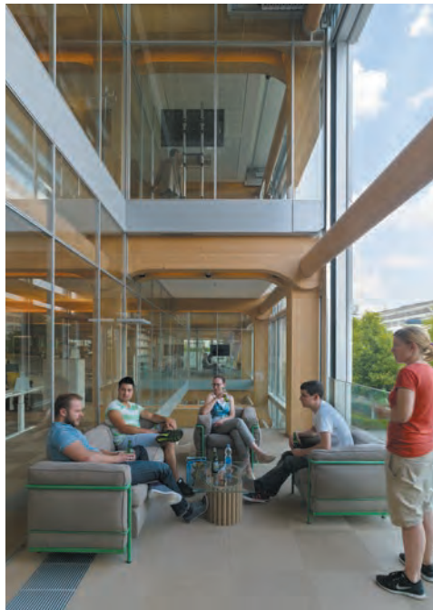
タメディア新社屋（スイス・チューリヒ） 右／建設中。左／完成後の建物内。スイスのメディア会社タメディアの新社屋として建てられた七階建ての木造建築。柱と梁とのジョイントも、梁を楕円形にして固定化することで鉄を使わないようにしている。なお、ポンピドゥー・センター・メスおよび当オフィスビルの構造用木材の加工は、いずれもスイスで行われた。（Didier Boy de la Tour）
