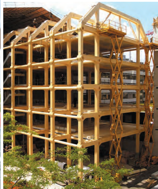
タメディア新社屋（スイス・チューリヒ） 右／建設中。左／完成後の建物内。スイスのメディア会社タメディアの新社屋として建てられた七階建ての木造建築。柱と梁とのジョイントも、梁を楕円形にして固定化することで鉄を使わないようにしている。なお、ポンピドゥー・センター・メスおよび当オフィスビルの構造用木材の加工は、いずれもスイスで行われた。（Didier Boy de la Tour）
