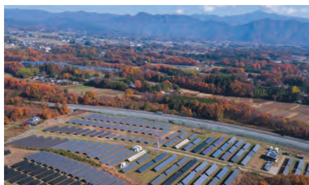
上／尾白川渓谷にかかる吊り橋を渡って進むルートは、人気のトレッキングコース。下／日照時間日本一という自然の恵みを最大限活用する「北杜サイト太陽光発電所」。
