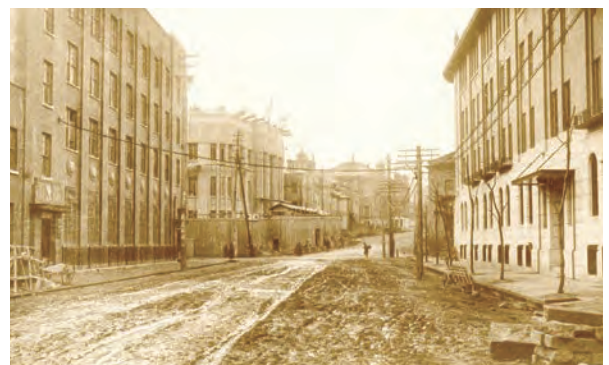
色内町十字街 1924年頃の様子。工事中の第一銀行の様子が見て取れる。左手前角 三菱銀行（1922年）、左奥角 第一銀行（1924年）、坂上奥左手 日本銀行（1912年）、右手前角 北海道拓殖銀行（1923年）（カッコ内は竣工年）
