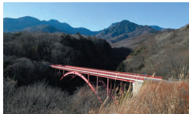
川俣川溪谷にかかる、長さ90メートルの東沢大橋。
