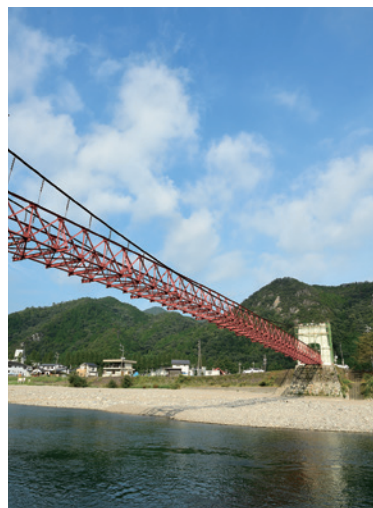
1916（大正5）年竣工。現存する吊り橋では日本最古とされる橋長113mの「美濃橋」。国指定重要文化財。現在工事中。
