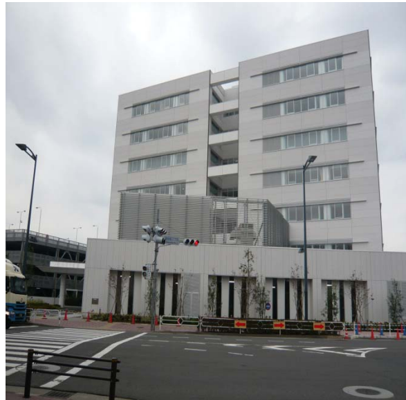
・立川合同庁舎（立川市緑町）
