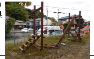
老朽化により破損した遊具
