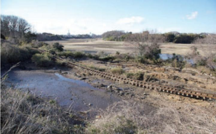
東日本大震災でひたちなか市にも大きな被害が。上／池が決壊して路盤が流され、線路が浮いた被災直後の湊線。下／地盤沈下と津波で破壊され、復旧を待つ那珂湊港。
