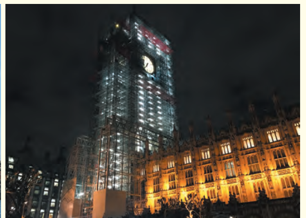
補修工場の足場に覆われている様子
