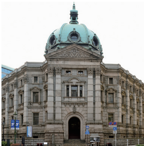
横浜正金銀行は、国立銀行条例により明治13年(1880)に設立された。写真は明治37年(1904)に建てられた同行本店。現在、神奈川県立歴史博物館として利用され、国の重要文化財・史跡に指定されている。(写真提供：神奈川県立歴史博物館)
