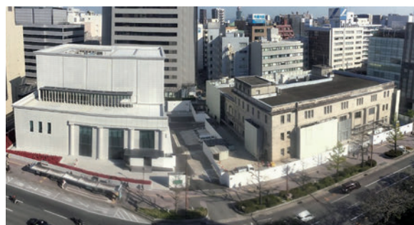
② 2019年12月：I期棟完成。2020年1月からI期棟での業務を開始。2020年2月より旧営業所の解体工事に着手。
