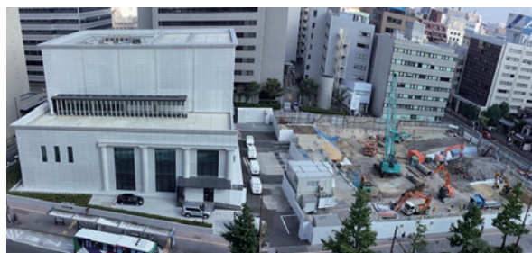
③ 2020年8月：II期棟新築工事着手。
