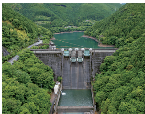
有田川に建設された二川ダムの維持放流水を活用する小水力発電は、新エネルギー財団による「平成28年度新エネ大賞」で資源エネルギー庁長官賞を受賞した。
