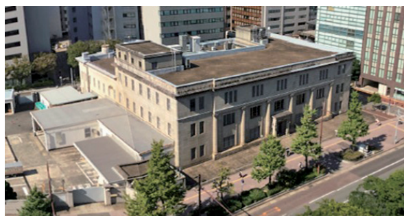
① 2017年10月：I期棟新築工事着手。
