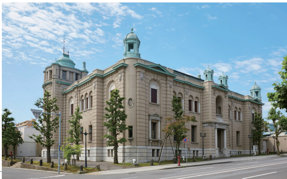
屋根の5つのドームが特徴的な旧小樽支店金融資料館。
