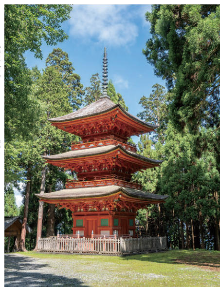
八鹿地区、妙見山の中腹に立つ「名草神社」は、写真の三重塔のほか本殿、拝殿が国の重要文化財に指定されている。三重塔は江戸期寛文年間に行われた出雲大社大改修の際、銘木として知られる妙見杉を提供した返礼として譲渡された。
