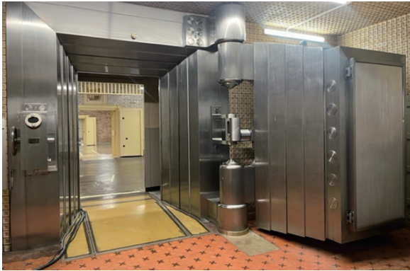
地下金庫の扉
