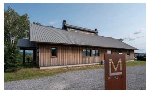
ショップの外観。北海道大学の築90年の製材工場を一度解体し、当麻町で組み直した。甲斐氏のこだわりと当麻町の支援で実現した。
