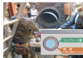
例：管路の耐震補強
