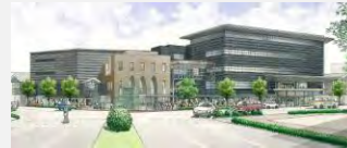
武蔵ヶ辻第四地区第一種市街地再開発事業 [石川県]
