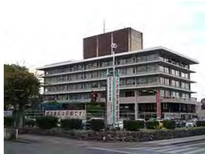
熊本地震で被災した八代市役所(地震前の状態) (出所)Wikipedia
