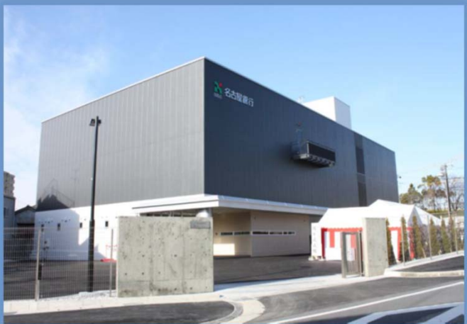
新設した瀬戸ドキュメントセンター
