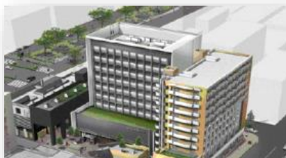
飯田市橋南第二地区 第一種市街地再開発事業 [長野県]
