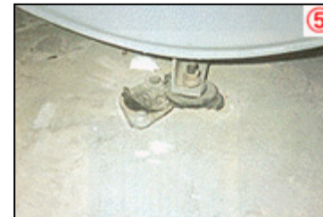
ボイラー・冷凍機
